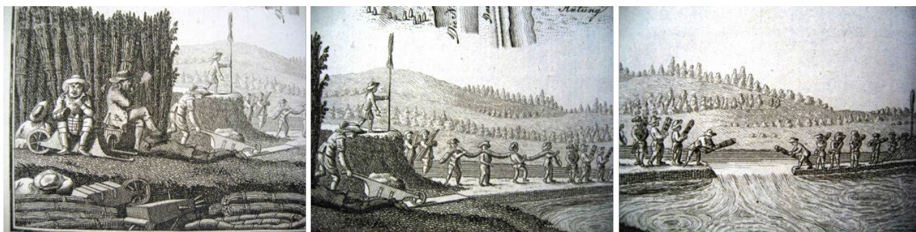
The Construction of Fascines in Prussia in the 18 th Century. Source: All three images are clips from a single image in H.C. Riedel, jun. Riedel, H. C., jun., “Über unvorhergesehene Unfälle bey Coupirung der Deich Durchbrüche,” Sammlung nützlicher Aufsätze und Nachrichten die Baukunst betreffend Bd. 3.1 (1799): 24-53, Table II. Images from Olesko (2010), courtesy of Kathryn M. Olesko, Department of History, Georgetown University.
